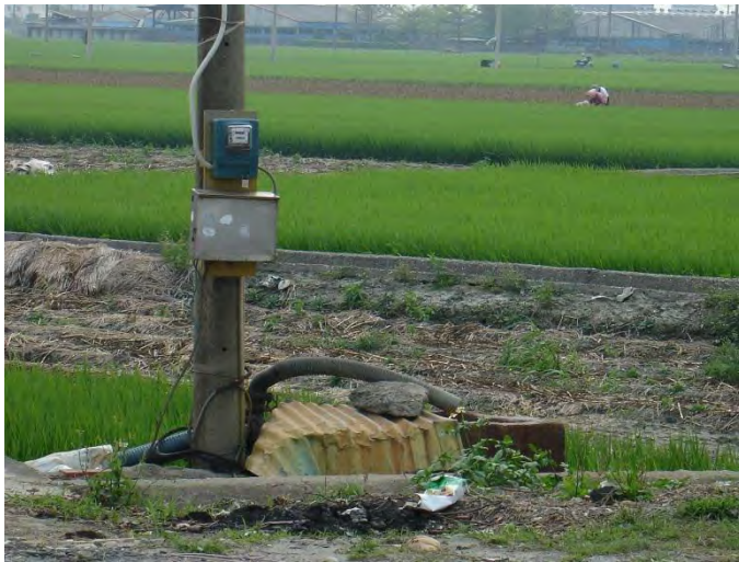
雲林縣(高鐵沿線)私有農業水井 1
